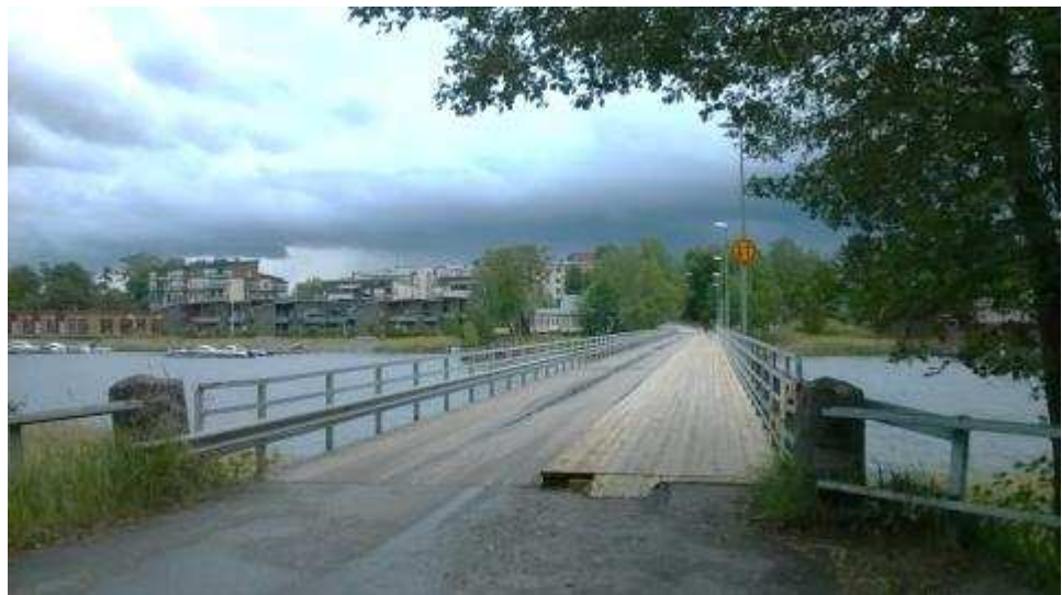
Alkuaan rautatiesillaksi rakennetun sillan tilalla on maantiesilta. Näkymä Kråkholmenilta mantereeseen suuntaan. Vasemmalla vastarannalla uusi rakentaminen korostaa rinnettä mataloitumalla rantaa kohti. (Kuva Eeva Eitsi)
