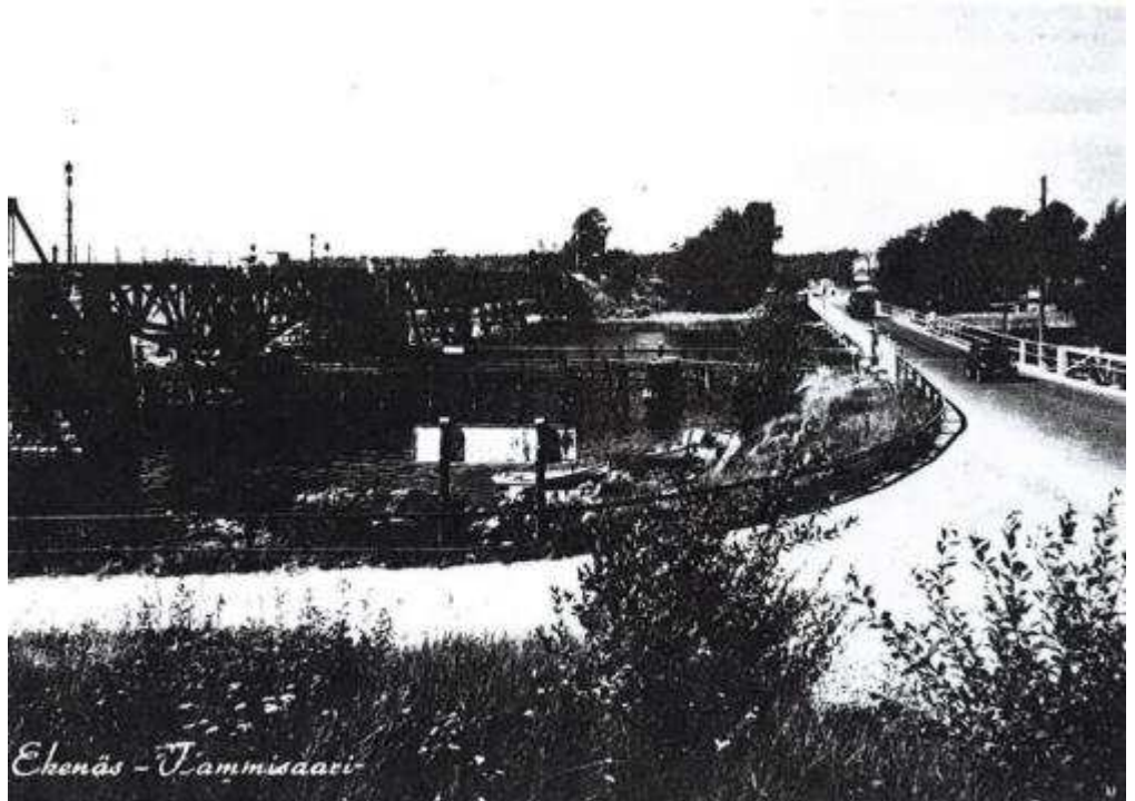
Kuva Pohjanpitäjänlahden silloista 1960-luvulta. Oikealla oleva maantiesilta on rakennettu aiemman rautatiesillan kohdalle ja vasemmalle rakennettiin 1910-12 uusi ristikkorakenteinen rautatiesilta. Ristikkorakenteet on myöhemmin korvattu teräspalkeilla. (Kuva TM/L-UM)
