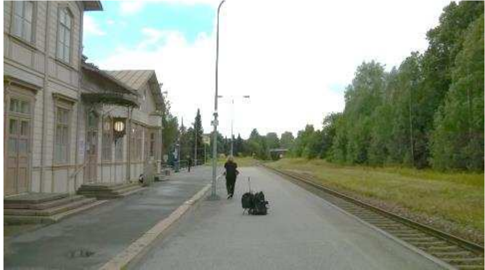
Näkymä Tammisaaren rautatieasemalta kauppasataman suuntaan. Alue kuuluu RKY-alueeseen. Rata kääntyy Ajurinpuiston sillan jälkeen hieman pohjoiseen. Näkymä on vehreä. (Kuva Eeva Eitsi)
