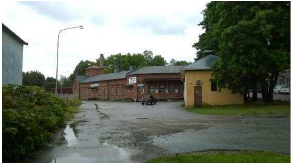
Frans Höijerin tehdasrakennukset ovat rakennettu useassa osassa. Vanhin osa on 1800-luvun jälkipuoliskolta. Rakennusta on sekä pidennetty että levennetty. Uusimmat osat lienevät vuodelta 1913 (Läntisen Uudenmaan rakennusten ja maiseman kulttuurihistoriallinen inventointi, 1993).
